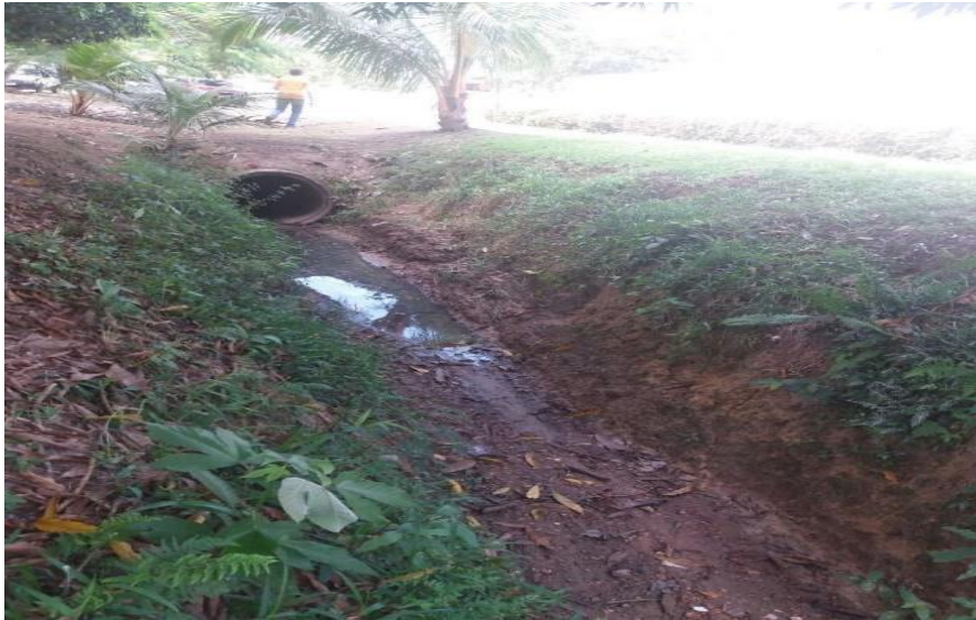
Figura 27: Despejo irregular de esgoto pluvial no interior do condomínio Amazon Garden
