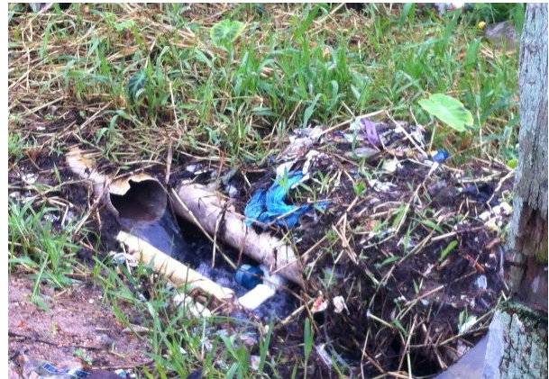
Figura 26: Tubulação improvisada
