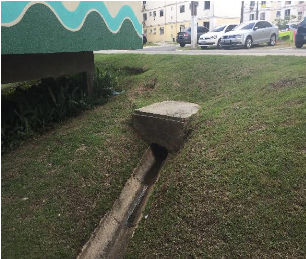
Figuras 35 e 36: Caixa de esgoto no residencial Viver Ananindeua (P05).
